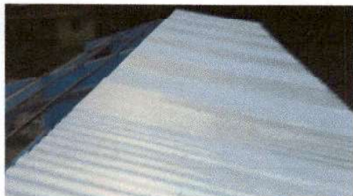
Foto1: Sustitución de lámina por oxidación y filtración de agua en tiempos de lluvia.
