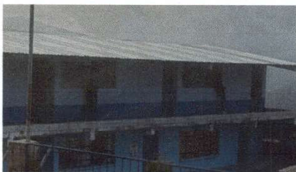
Foto 3: Sustitución de tres Puertas de metal.
