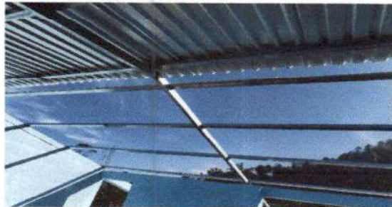
Foto 2: Sustitución de soporte de madera en mal estado por metal.
